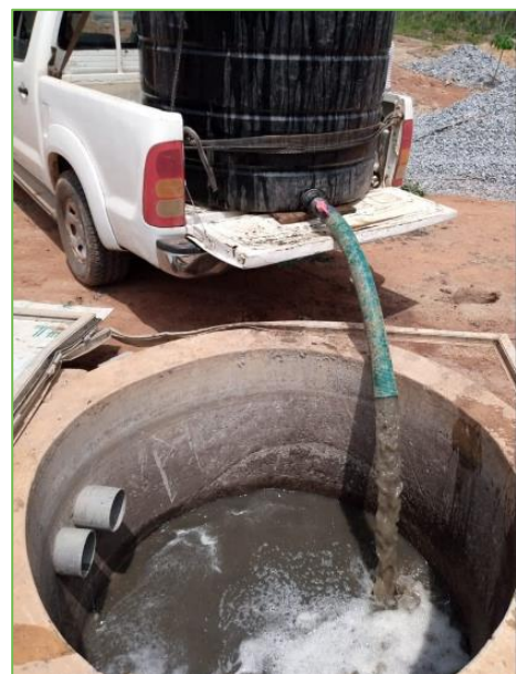
Die Abfälle werden in den Tank der Anlage eingefüllt.
