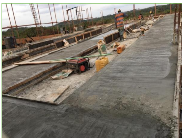
Mai 2020: Fundament gießen
