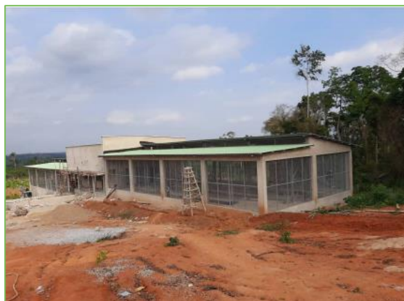
Juni 2021: Der Geflügelstall nimmt Form an.
