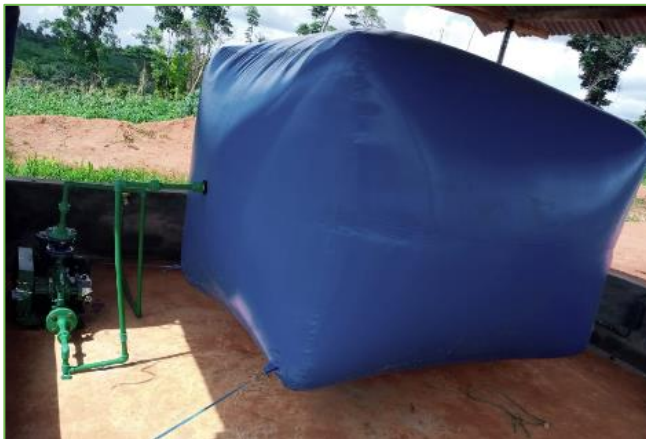
Aktuell wird das erzeugte Gas noch gesammelt. Je mehr Tiere auf der Farm leben, umso mehr Biogas kann mit der Zeit erzeugt werden.
