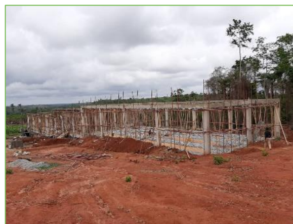
Mai 2020: Grundmauern Geflügelstall
