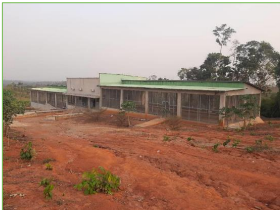
Der Geflügelstall ist fertiggestellt, einschließlich der Aufenthalts- und Sanitarräume. © SOS-Nigeria
